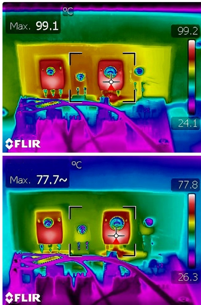
Figuur 3: Infraroodbeelden in valse kleuren van de gemonteerde print van de elektronische belasting. Boven: zonder ventilator. Met een draaiende ventilator daalt de temperatuur met meer dan 20 K (onder)!
